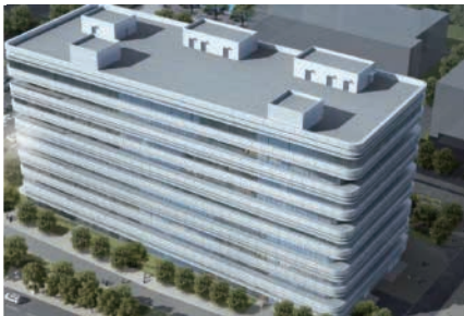
生物药研发新大楼（#11，在建）
